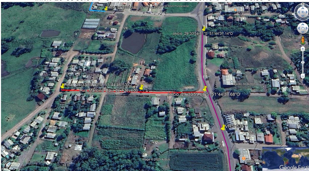
Fonte: Google Earth(2025) – Localização rua Marcírio Davi de Azevedo
