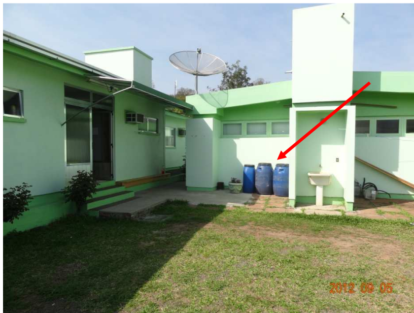
Fonte: Empresa Executora.
