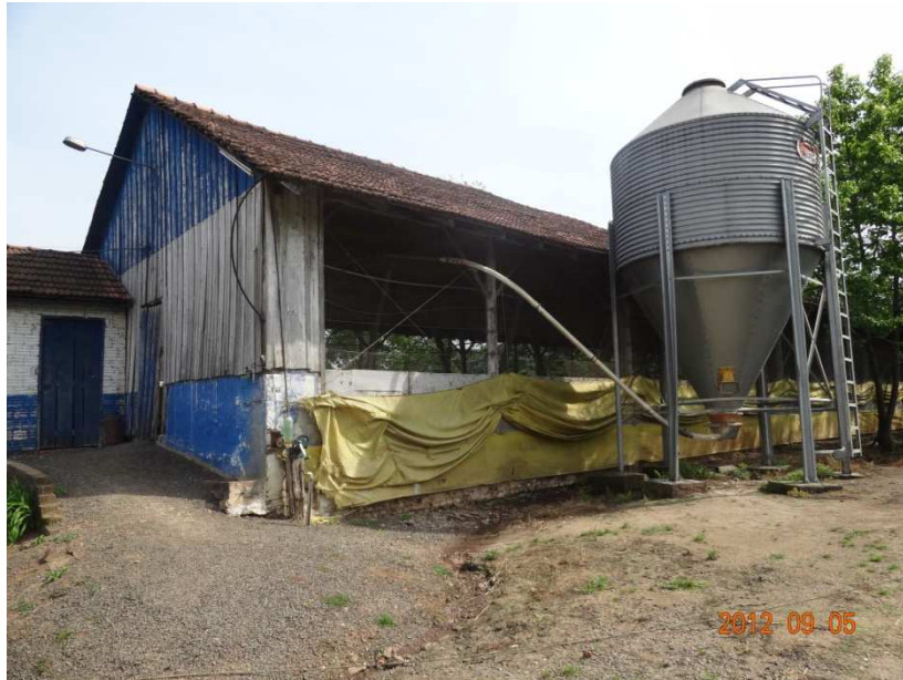
Fonte: Empresa executora.
