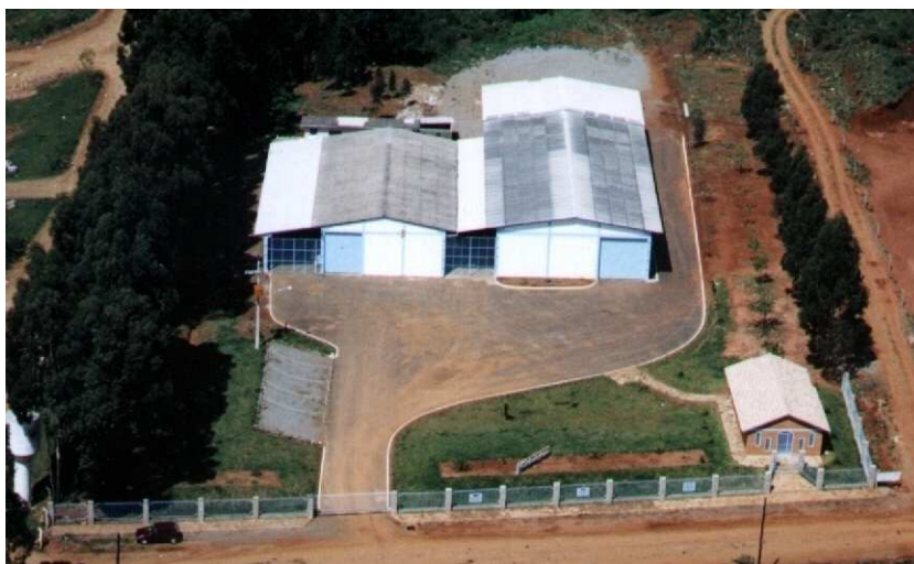
Figura 63 - Vista aérea da Empresa Cinbalagens.
