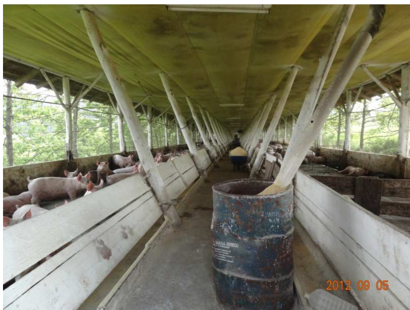
Fonte: Empresa executora.
