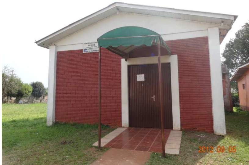
Fonte: Empresa Executora.
